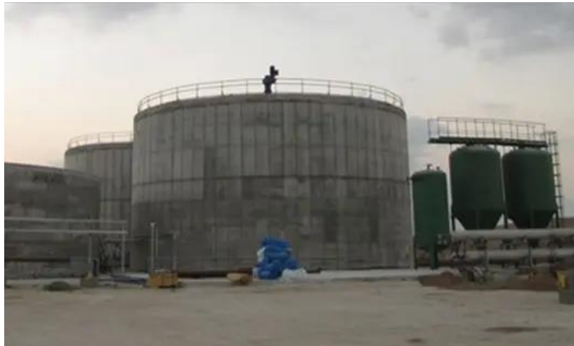
Figura 2 - Tanques de concreto que fazem parte da planta de Be'er Tuvia
