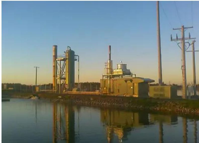
Figura 3 - Instalações da usina de Tatura
